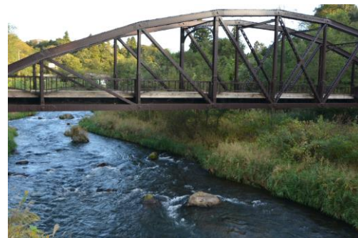
日橋第四発電所、切立橋
