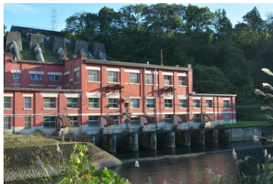
猪苗代第二発電所
