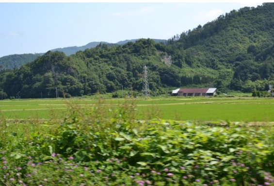
会津若松市大戸町雨屋 雨屋工場跡
